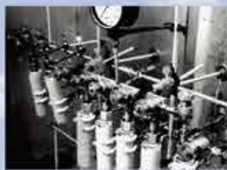
榊原開発による無水フッ化水素反応装置(ペプチド合成における脱保護に使用) HF-Reaction Apparatus by Sakakibara's development. (It is a safe cleavage strategy used in peptide synthesis.)
